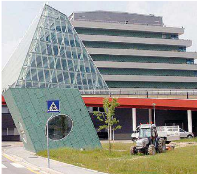
L'ingresso del pronto soccorso dell'ospedale dell'Angelo
